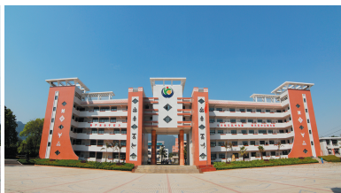
▲乳源中学创强后改建的综合楼
